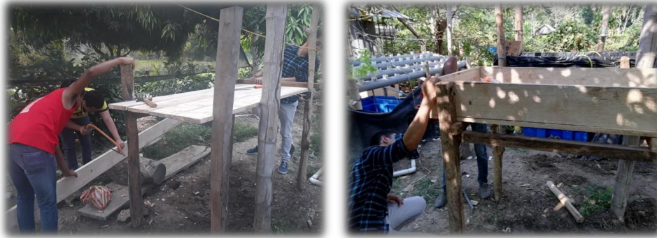
Figura2. Construcción del Sistema Acuapónico.
