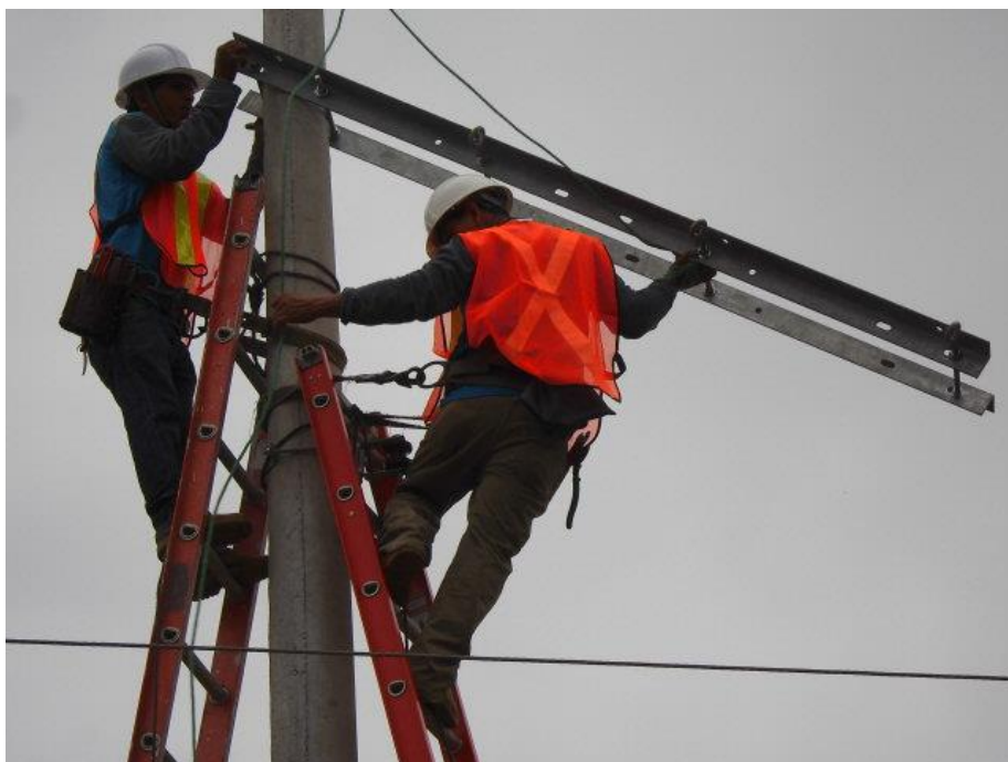
Foto 1. Práctica en altura armando estructura en poste.
