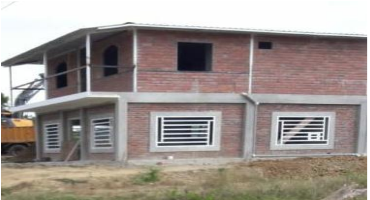
Ilustración 1-b (mampostería de ladrillos burrito)
