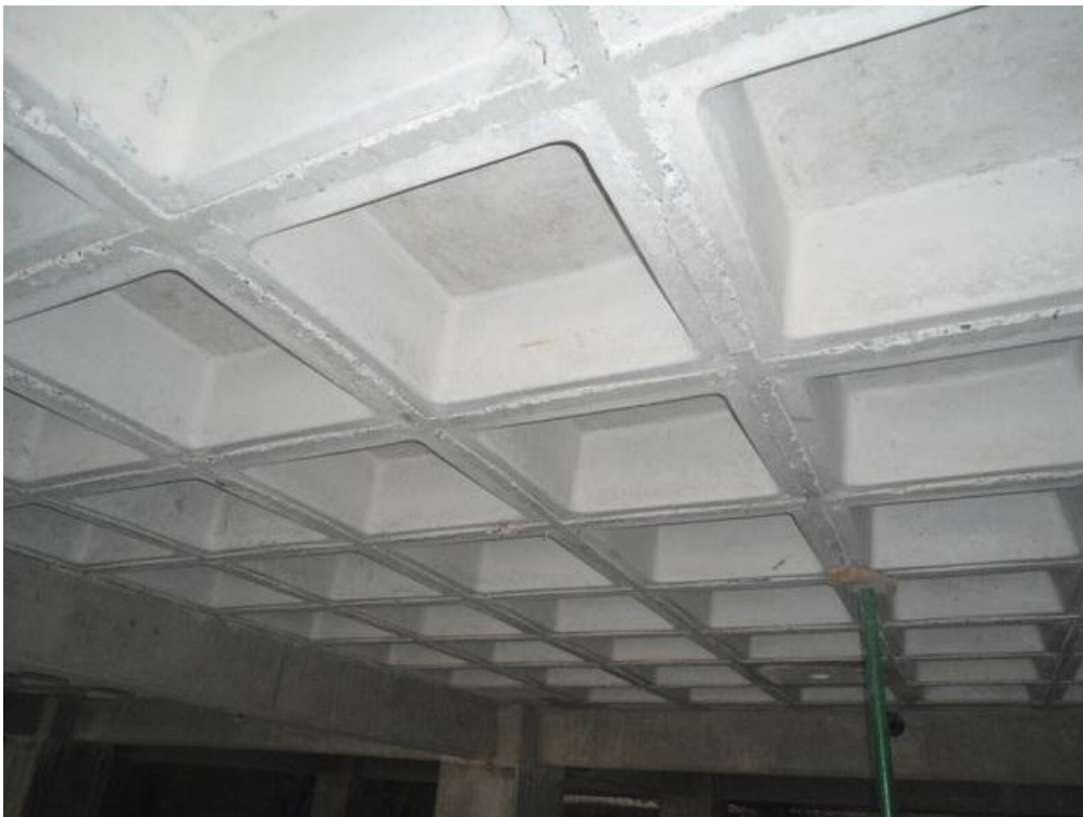
Ilustración 3-b (acabado de losa con casetones de plástico)
