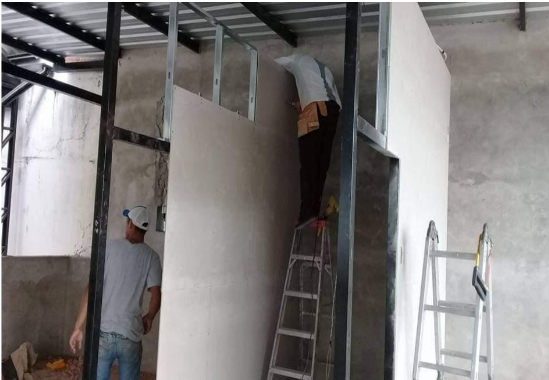
Ilustración 5-b (gypsum en obra)
