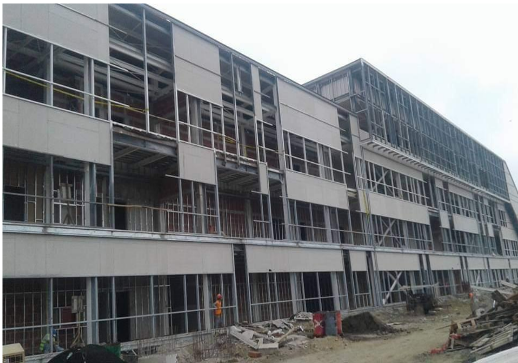
Ilustración 4-b (Fachadas con fibrocemento "IESS MANTA")
