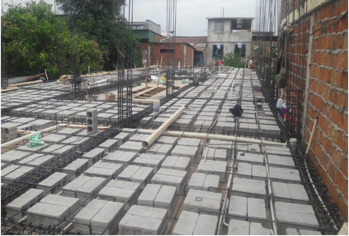
Ilustración 1-0-a (bloques hormigón en losas)
