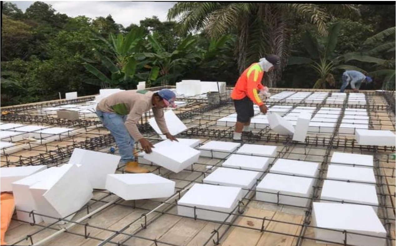
Ilustración 2-b (colocación en obra del poliestireno expandido)
