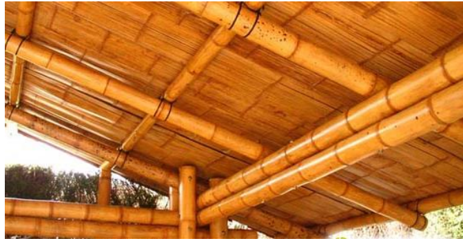
Figura 16. Estructura de cubierta y tumbado en guadua.
